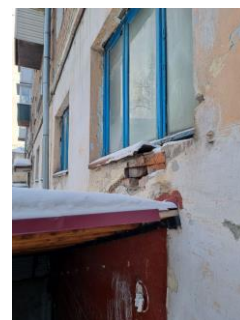
Рисунок 4 – Выкрашивание раствора
