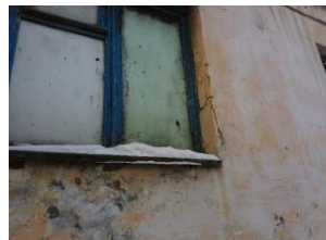
Рисунок 3 – Следы протечек
