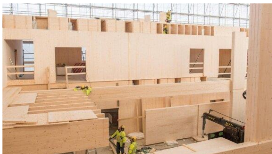
Рисунок 2 – Возведение дома из CLT-панелей.
