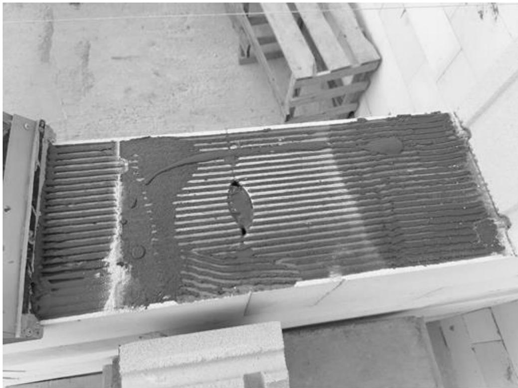
Рисунок 1 – Укладка теплого раствора при устройстве стен из пеноблоков
