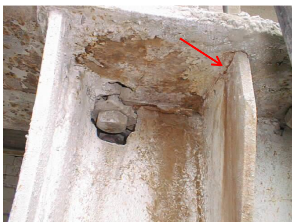
Рисунок 3 – Трещины в сварных швах консолей колонн
