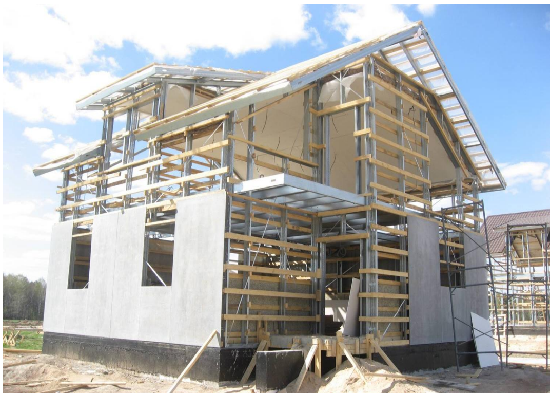
Рисунок 1 – Строительство каркасно-монолитного дома, утепленного пенобетоном
