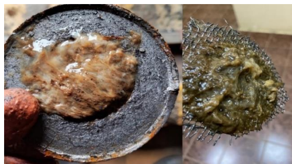
Рисунок 2 – Фильтрующая сетка на трубопроводе подачи оборотной воды на производстве полистирола промышленной площадки АО «Ангарский завод полимеров»
