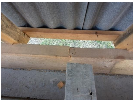
Рисунок 2 – Незакрепленный элемент.
