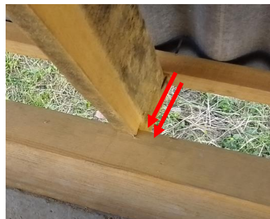
Рисунок 4 – Крепление стропил (2 гвоздя).
