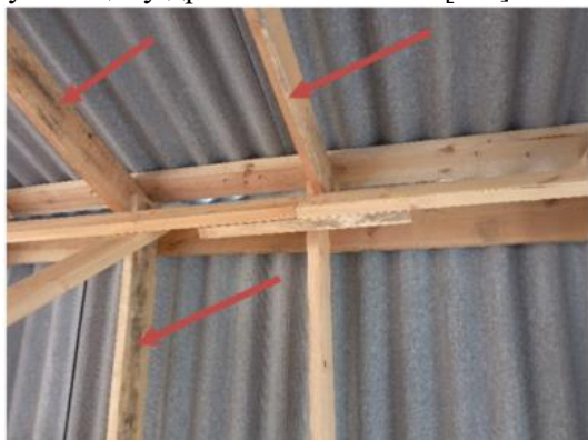
Рисунок 5 – Следы биоповреждений.
