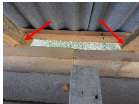
Рисунок 3 – Крепление стропил (1 гвоздь).
