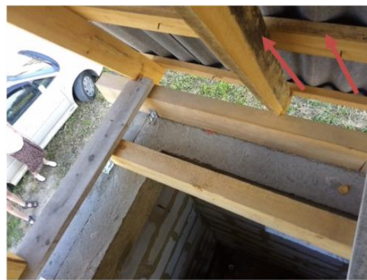
Рисунок 6 – Следы биоповреждений.
