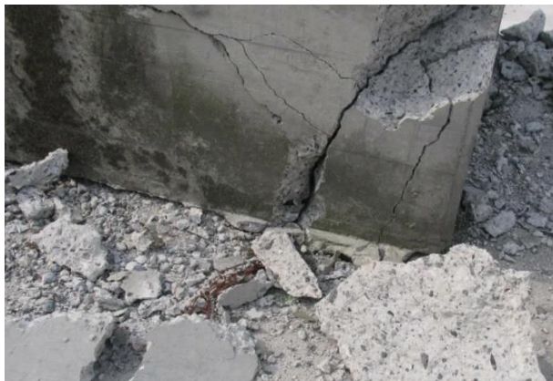
Рисунок 3 – Разрушение фундамента.
