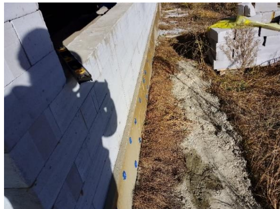
Рисунок 4 – Искривление отмостки.
